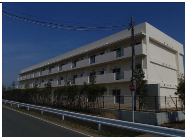
②建物全景 南側より撮影
