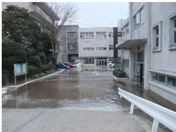
③津波被災状況
