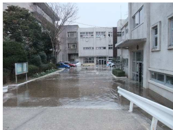
③津波被災状況
