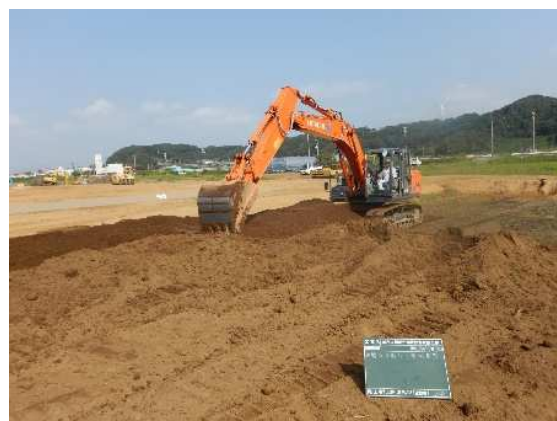
④盛土作業
