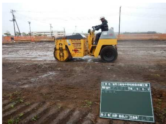
⑤転圧作業
