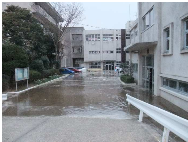
③津波被災状況
