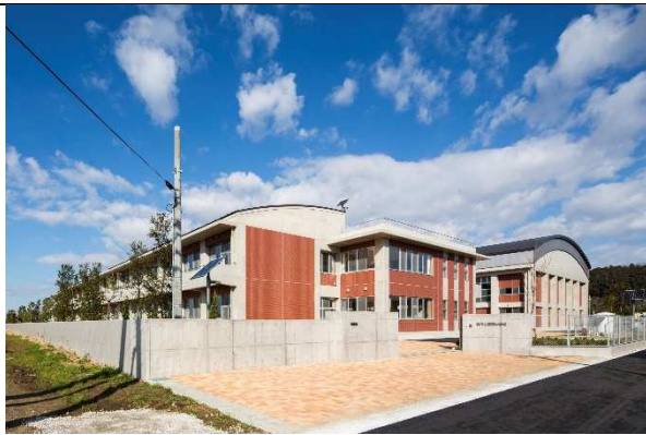
⑦移転改築後 全景
