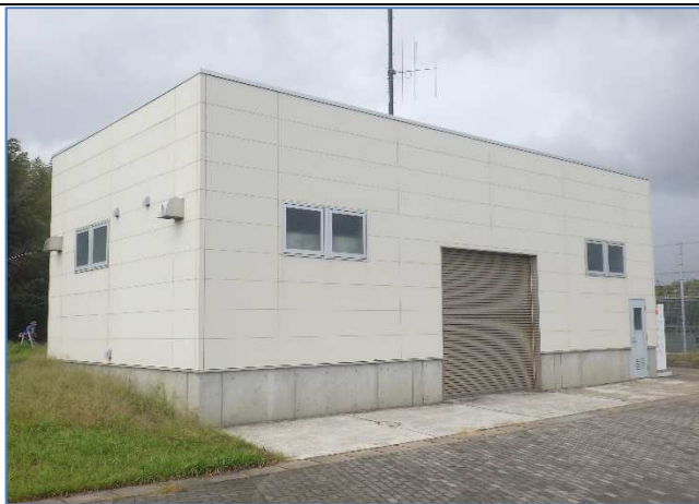
①防災備蓄倉庫外観
