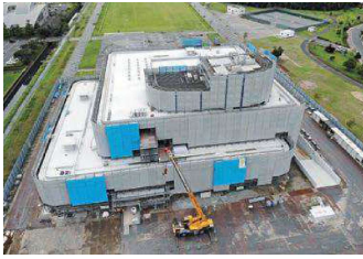
建設が進む旭市役所新庁舎
