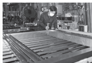
扉を組み立てる作業
