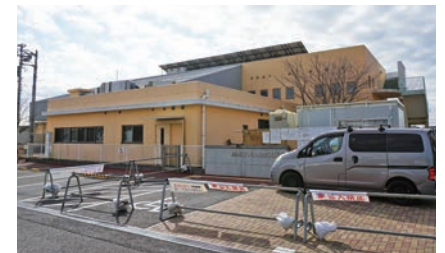
改修工事中のいいおか保育所
