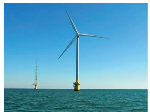
銚子沖に設置している洋上風力発電の実証機
