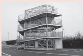
津波避難タワー
