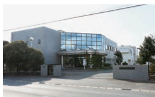
下水道終末処理場(旭市浄化センター)
