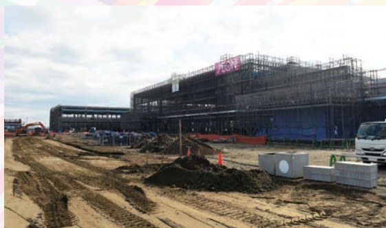
6位／工事が進む「みらいあさひ」
