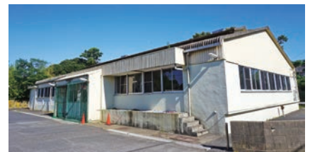
解体予定の旭市卓球場
