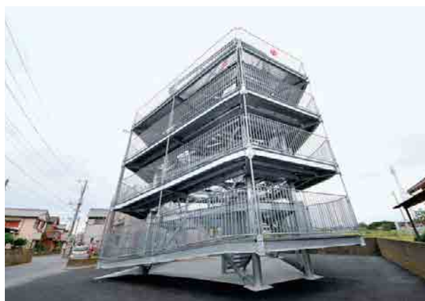
津波避難タワー
