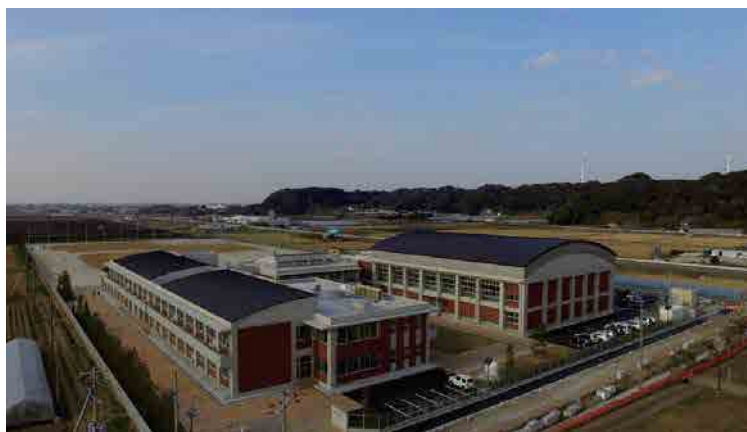
移転改築された飯岡中学校
