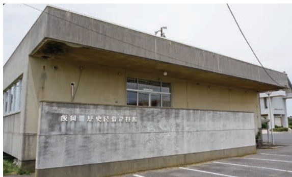
解体予定の飯岡歴史民俗資料館
