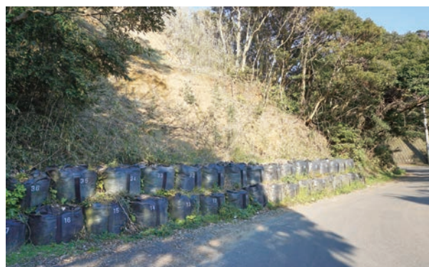
大型土のうを設置している横根地区急傾斜地
