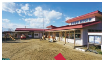
解体予定の旧園舎
