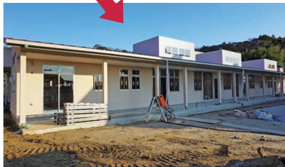
完成間近の新園舎。令和2年4月より開設
