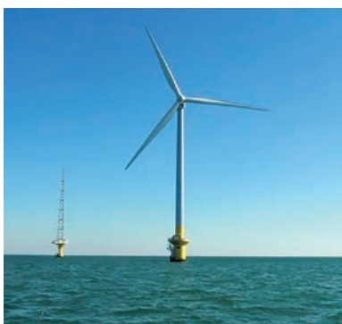
銚子沖に設置している実証機
