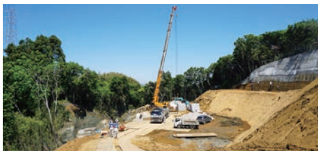
建設中のごみ最終処分場
