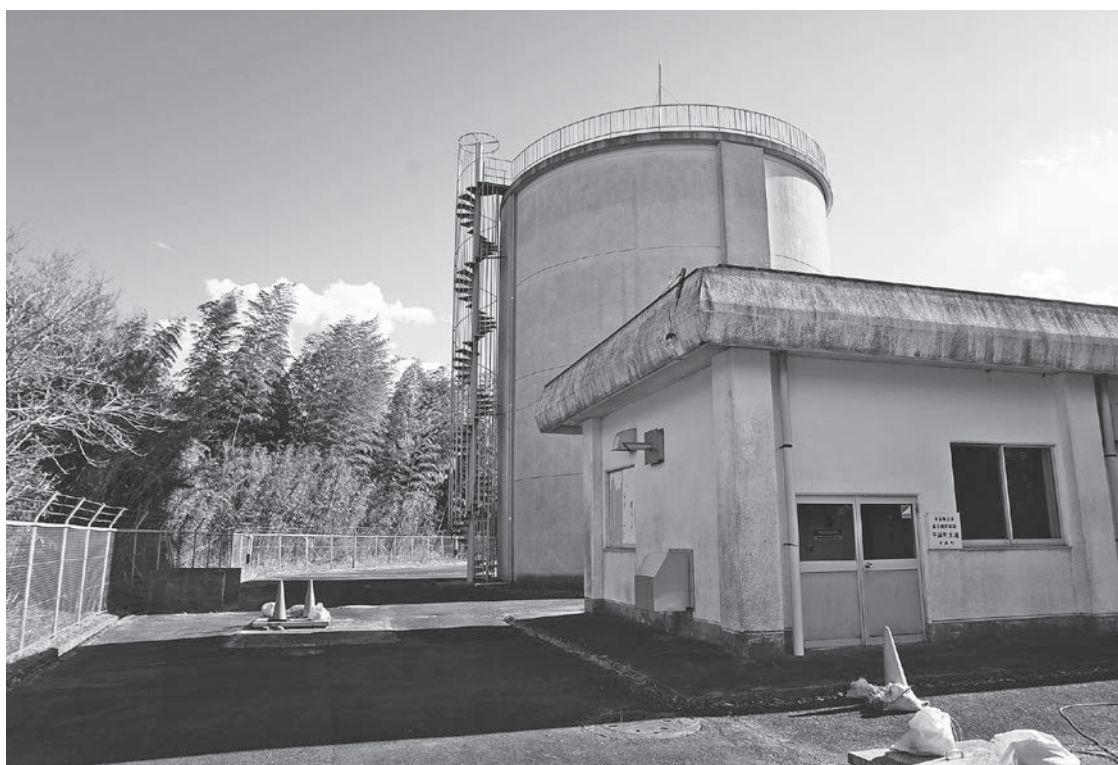
干潟地区にある水道施設
