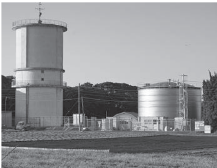
増設工事が完了した海上配水池
