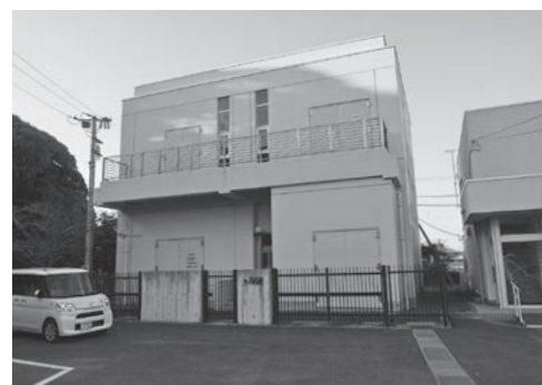
本庁舎敷地内にある中央汚水ポンプ場
