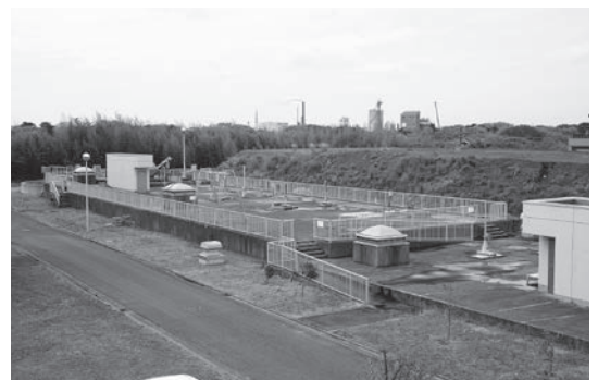
下水道の汚水処理施設
