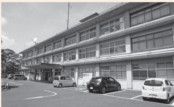
老朽化と耐震不足が問題となっている本庁舎
