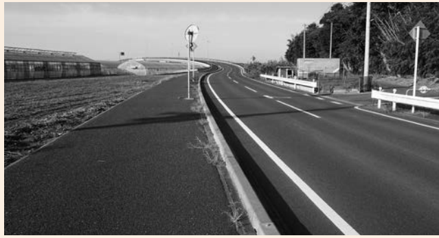
「あさひ中央橋」へ続く旭中央病院アクセス道
