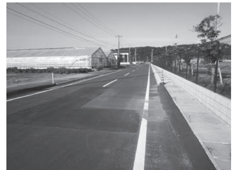
一部開通した津波避難道路横根三川線
