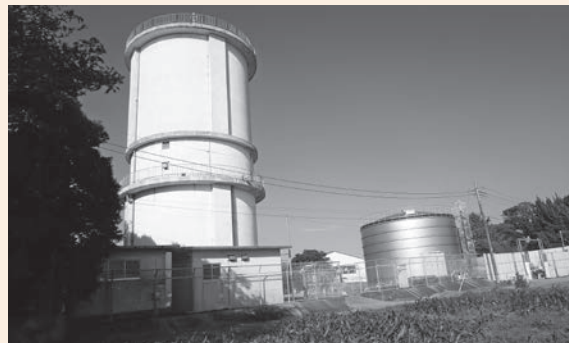
工事が進む海上配水池
