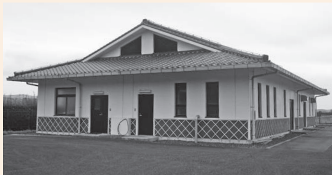
琴田地区にある農業集落排水処理施設
