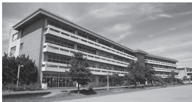
大規模改造工事が行われる旭一中校舎
