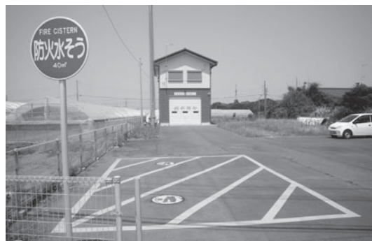
飯岡地区で整備された防火水そう
