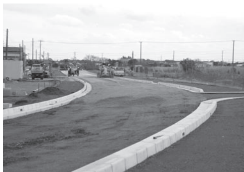
工事が進む三川蛇園線
