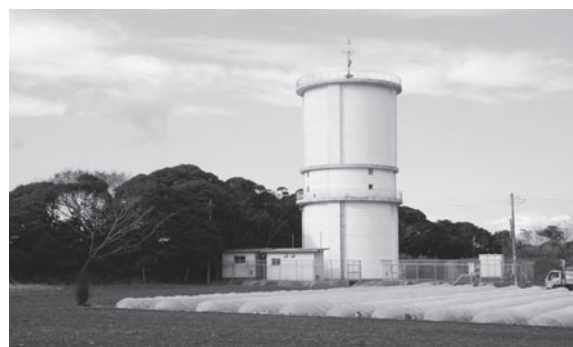
海上地区にある配水池
