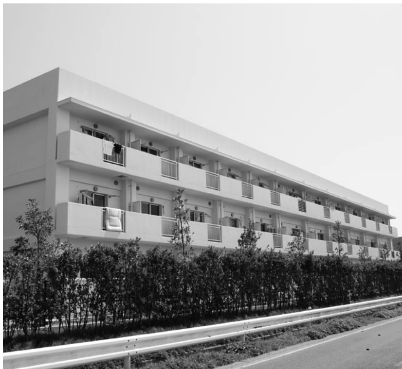
入居が始まった災害公営住宅(萩園住宅)
