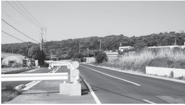
建設中の三川蛇園線
