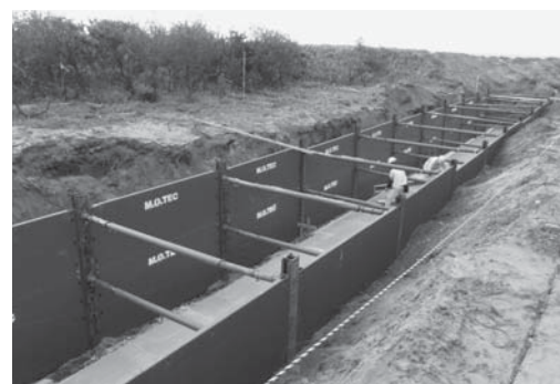
三川海岸から整備が進む排水路
