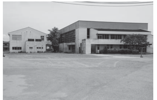
解体が予定されている旧海上中学校体育館
