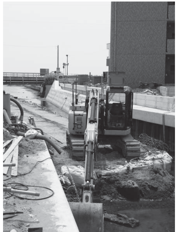
矢指川の震災復旧工事
