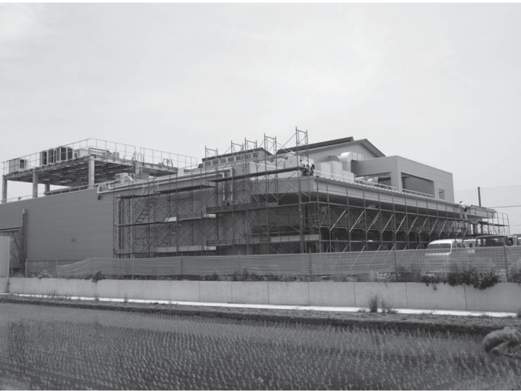
工事が進む(新)第二学校給食センター
