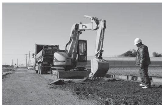
液状化による市道の復旧工事
