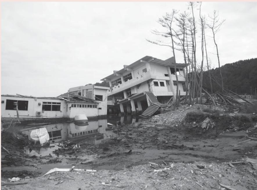
津波により倒壊したレストハウス
