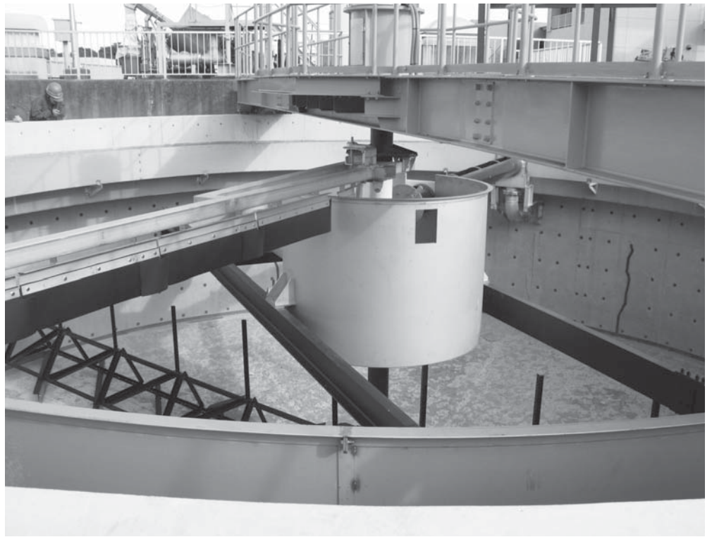
旭市浄化センターの水処理設備工事
