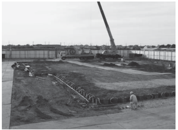
(仮称) 旭市第二学校給食センター工事
