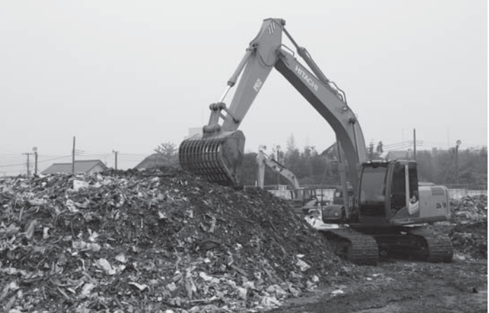
旧海上中学校での瓦れき処理
