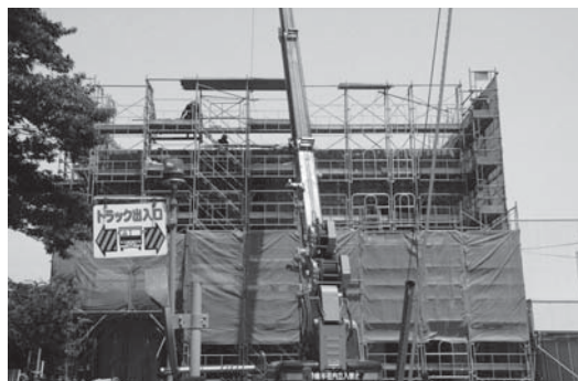
旭中央汚水ポンプ場
