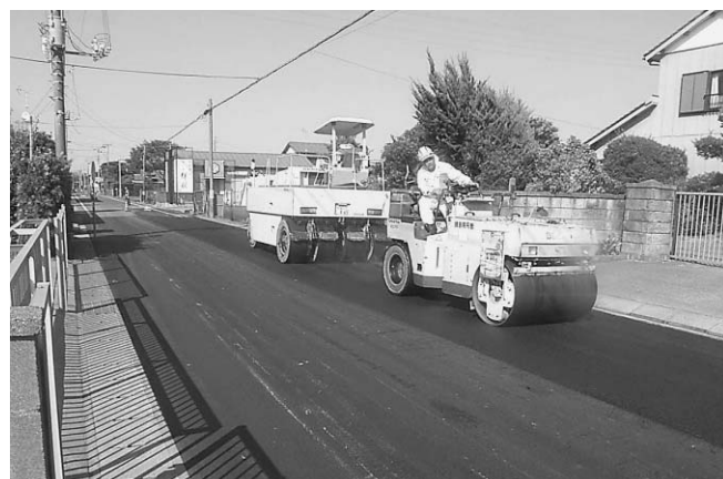
舗装の補修工事が行われる市道
