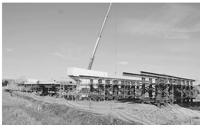
入札が行われて工事が進む01-032号線
