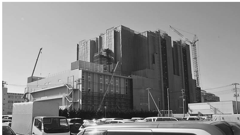
工事が進む旭中央病院新病棟
