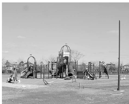
工事が行われている袋公園
