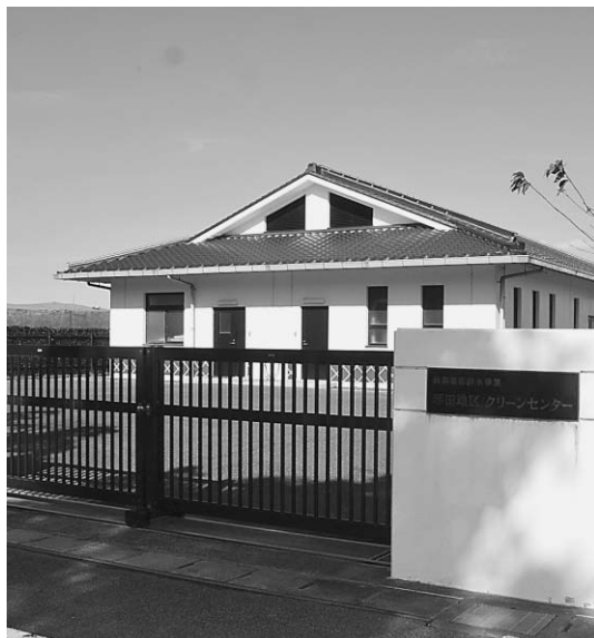
農業集落排水事業琴田地区クリーンセンター
