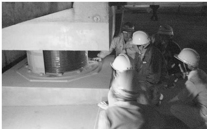
旭中央病院新病棟の免震装置
