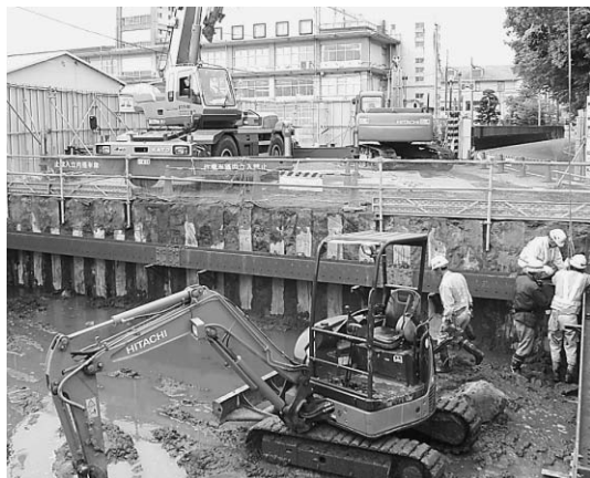
下水道、旭中央汚水ポンプ場建設現場
