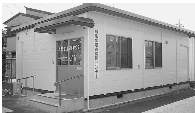
利用者のサービス向上を目的に設置された水道お客様センター
