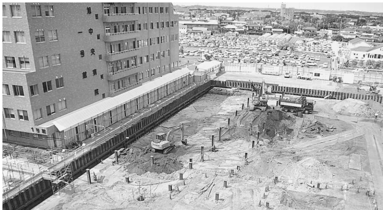
新本館建設工事の状況（4月27日撮影）
