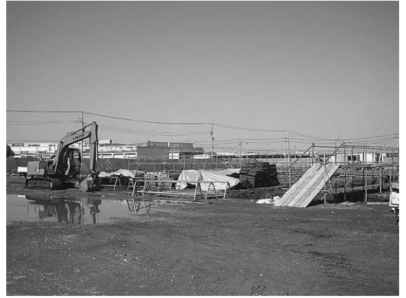
進出が決まった農産物加工工場建設の様子
