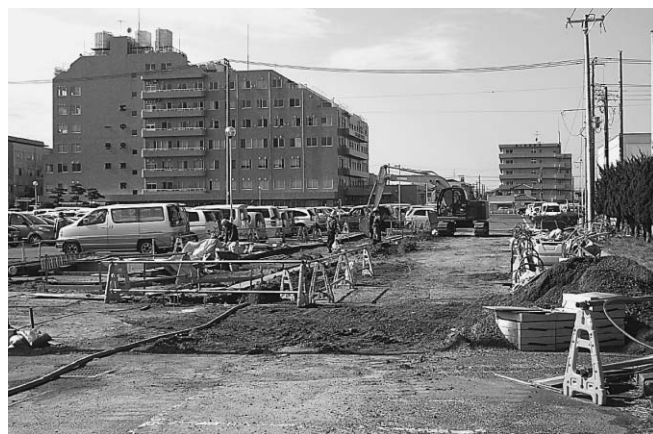
新本館建設に伴う市道付け替え工事
