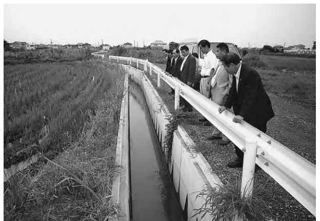
昨年度整備した排水路(八地先)を視察する建設経済常任委員
