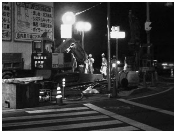
本年11月の夜間工事の状況
