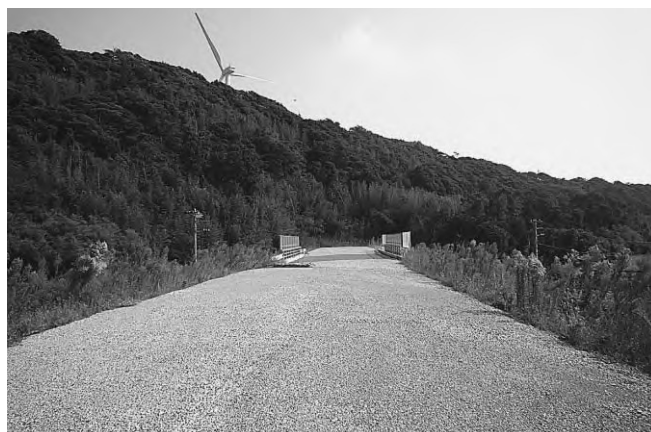
トンネル工事前の清滝バイパス
