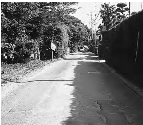
拡幅が予定されている塙新町の幹線市道
