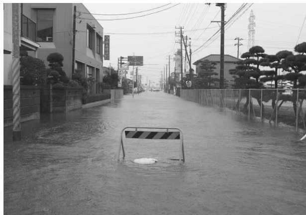
平成18年4月12日大雨で冠水した県道飯岡停車場線
