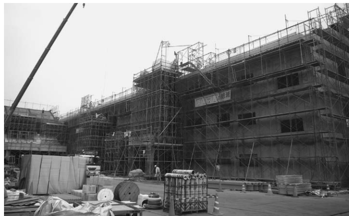
校舎改築工事が進む第二中学校
