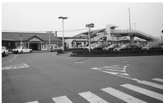
八日市場駅の自由通路(歩道橋)とエレベーター
