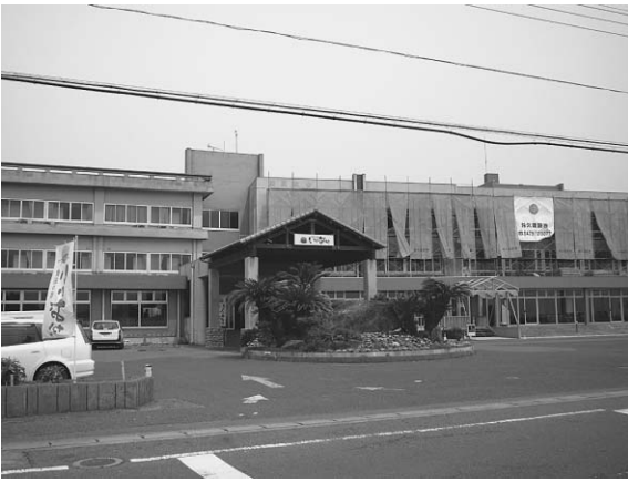
食彩の宿いいおか1階食堂改修工事が終了、2階客室改修工事へ
