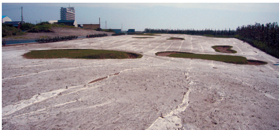
来年春の完成を目指して工事が進むあさひ健康パーク
