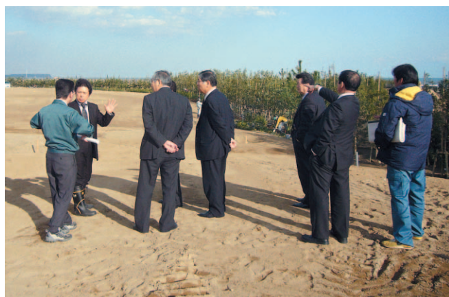
工事が進むあさひ健康パークを視察する建設経済常任委員会委員
