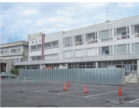
改修工事が始まった飯岡荘
