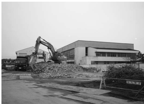
旧海上中学校校舎解体工事の様子
