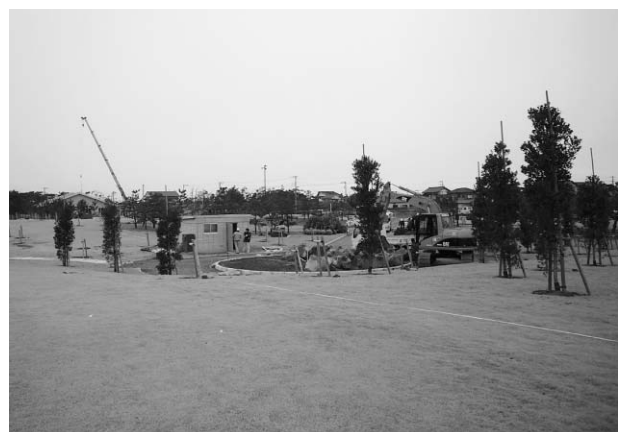
工事が着々と進むあさひパークゴルフ場
