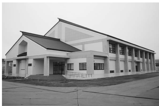
完成間近な二中体育館
