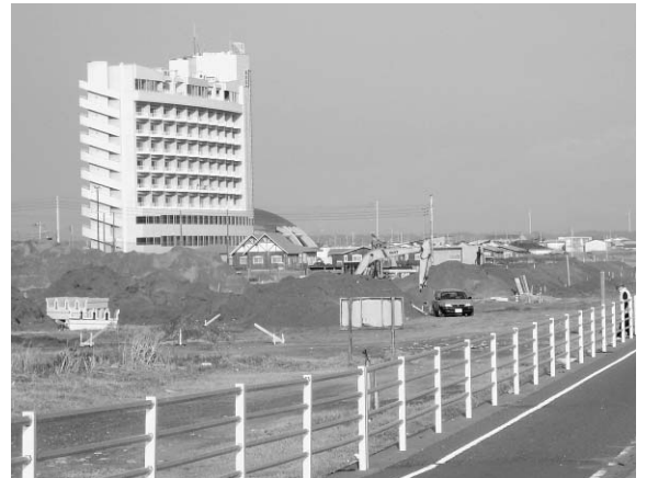
造成工事が進むパークゴルフ場予定地
