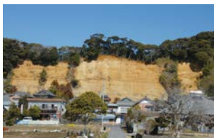
100メートルにわたり崖崩れが発生
