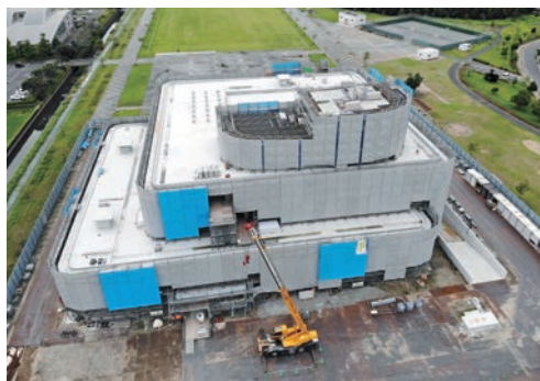
建設が進む旭市役所新庁舎
