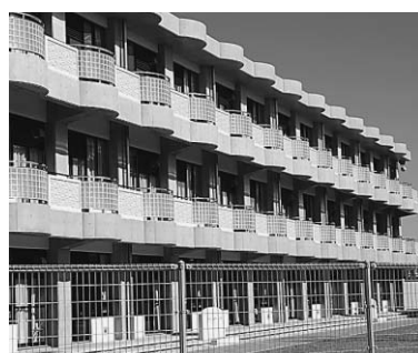
▲耐震化が進む学校施設（第二中）
