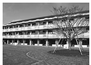
11/28 内装には木材をふんだんに使用した校舎が完成
