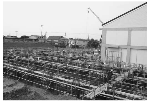
▲建設が進む第二中学校
