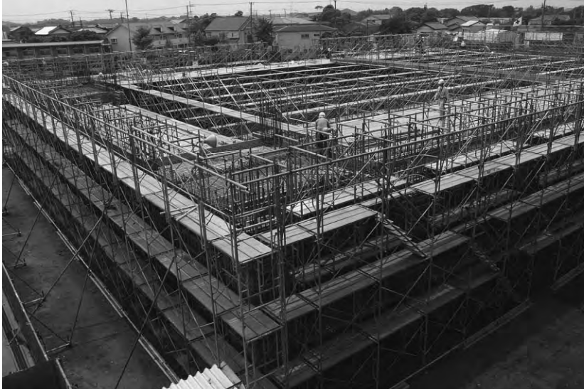
▲建築が進む二中屋内運動場
