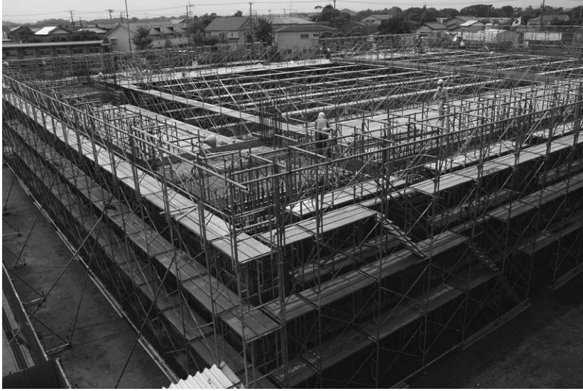
▲建築が進む二中屋内運動場
