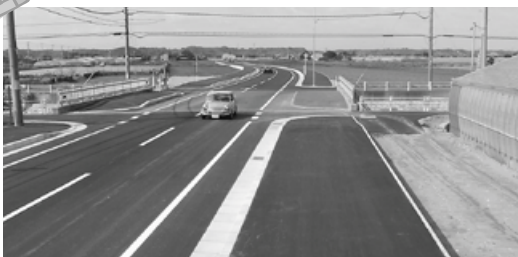
国道126号と広域農道を結ぶ、 谷丁場遊正線が開通。(3月)
